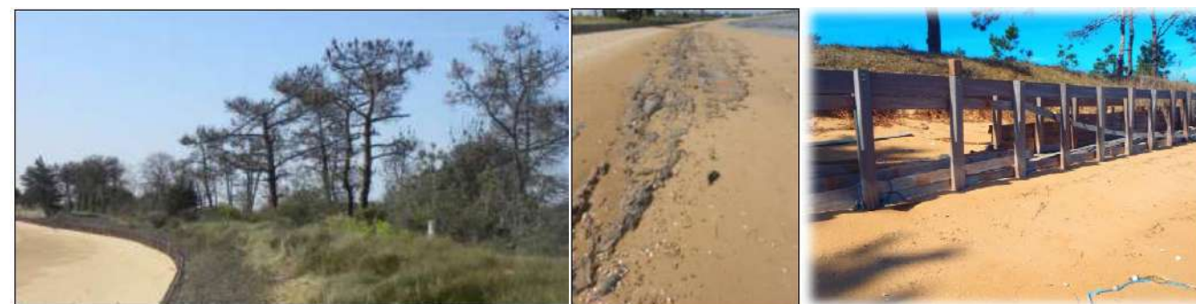
Figure 24 : Cordon dunaire entre Fort Royer et Bellevue (gauche) - Couche d'argile rendue visible suite à l'érosion (centre) - Destruction des palplanches en bois (droite) - Source : RNN Moëze-Oléron
