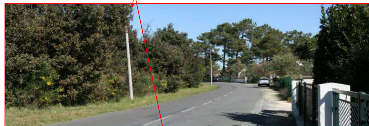
Vue du tronçon Sud de la section 58
