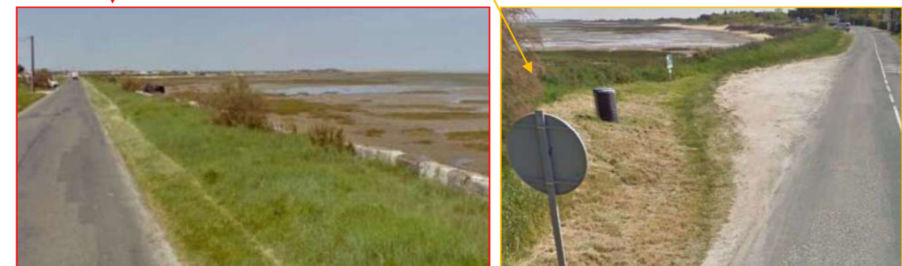
Vues de la digue Saint martin (à gauche) et de milieu dunaire (à droite)
